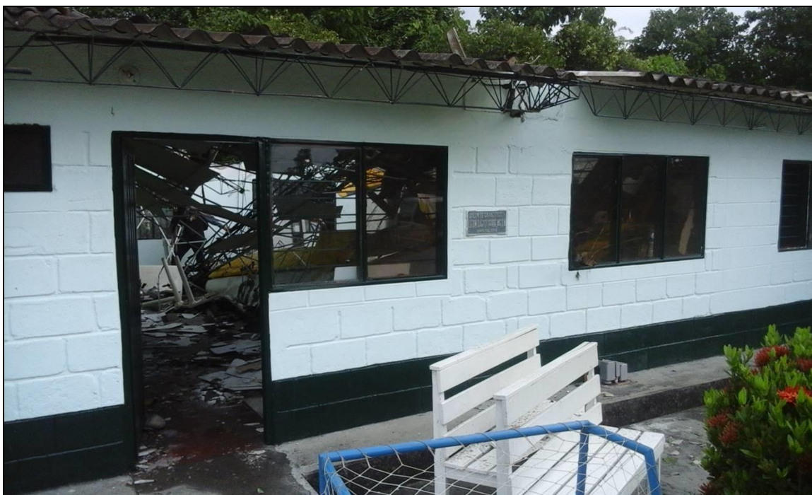
Estado final de la edificación
